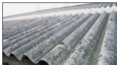
© INRS Toiture en amiantociment
