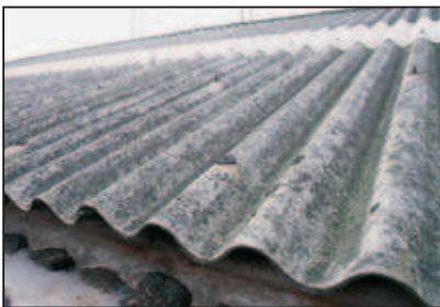
©INRS Toiture en amiante ciment
