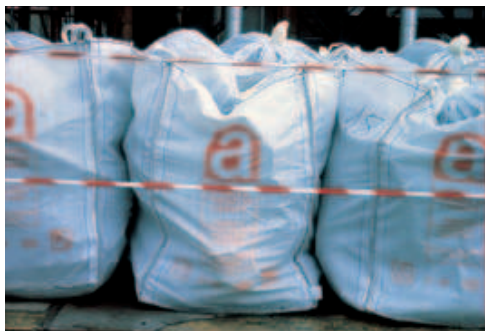
© INRS Déchets amiantés
