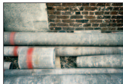
© INRS Canalisation en amiante ciment
