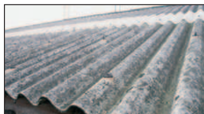
© INRS Toiture en amiantociment
