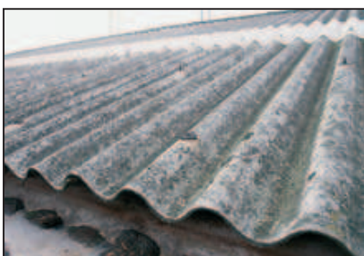
© INRS Toiture en amiante ciment
