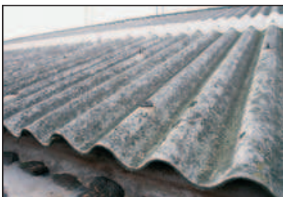
© INRS Toiture en amiante ciment
