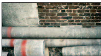
© INRS Canalisation en amiantociment
