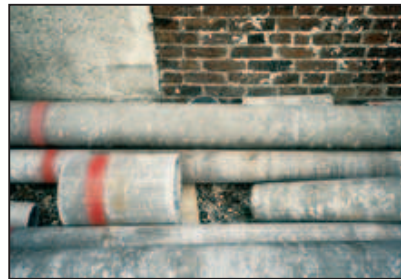
© INRS Canalisation en amiante
