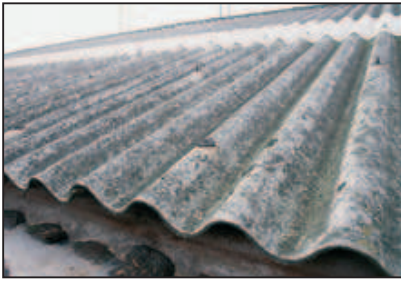
Crédits : INRS Toiture en amiante ciment
