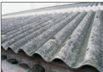
©INRS Toiture en amiante ciment
