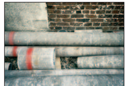
© INRS Canalisation en amiante ciment
