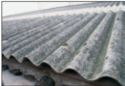
© INRS Toiture en amiante ciment
