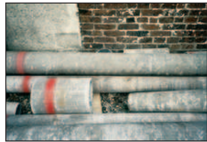
Crédits : INRS Canalisation en amiante ciment
