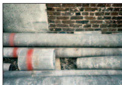
© INRS Canalisation en amiante ciment
